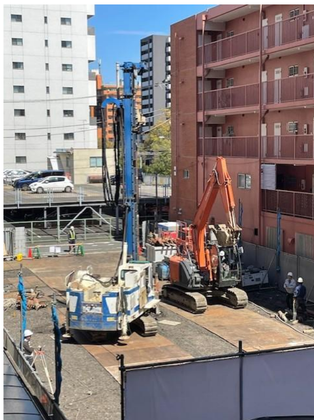
試験杭を打つ様子。 今回、摩擦杭を使った工法が予定されています。
